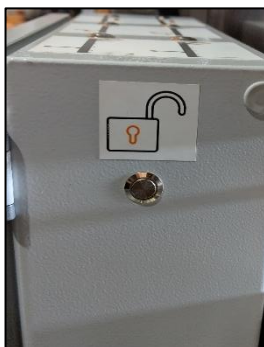
Abbildung 11: Manuelle Notbedienung am Schaltschrank, Zweihandbedienung: Taster an Seitenwand (links) gibt die Funktionstasten (rechts) frei
